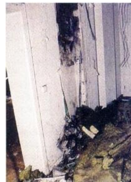
škoda způsobená požárem vzniklým od rozvaděče
